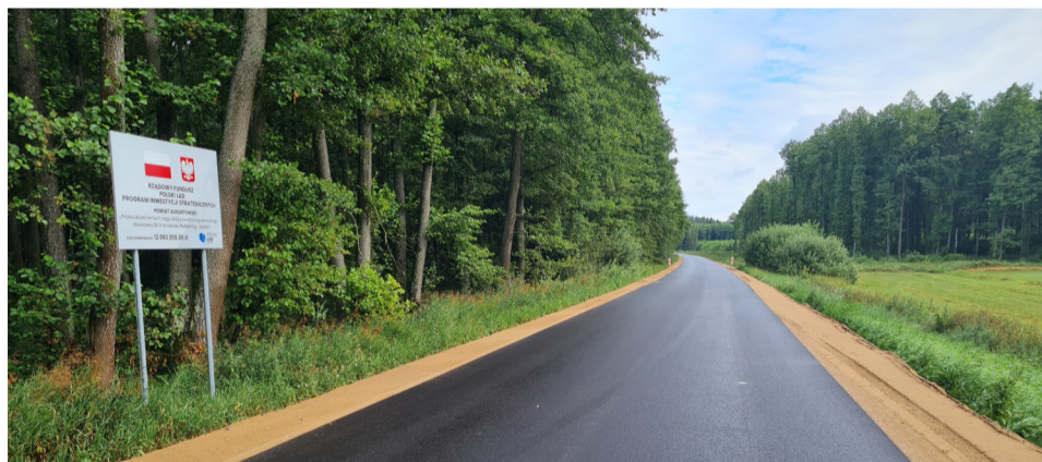
Przebudowana droga Białobrzegi - Bór - Sztabin jako obwodnica DK8
